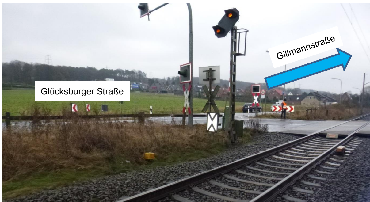
Abbildung 16: Bahnübergang „Glücksburger Straße“ mit Blick in Richtung Gillmannstraße 93
